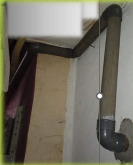
Toilet vent line
